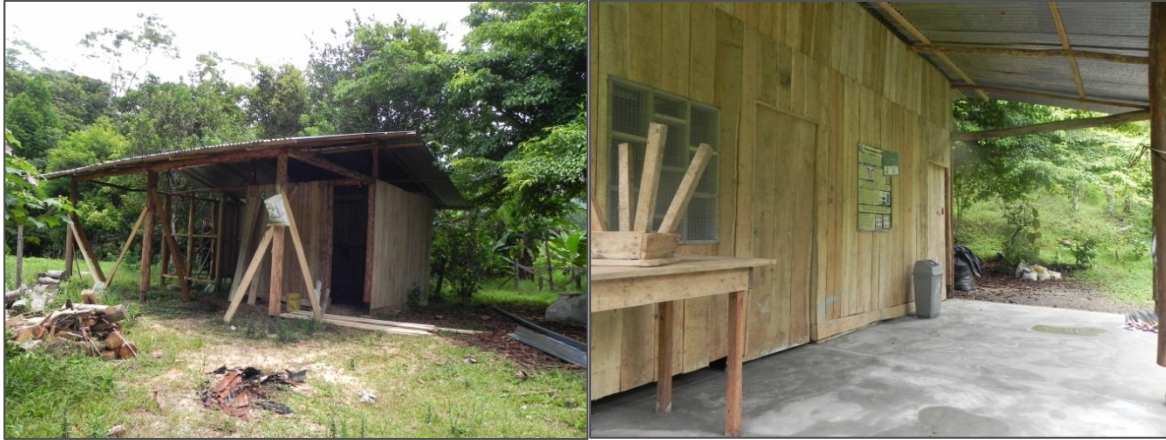
Figura 5. Construcción de una casa en Finca La Bolsa.
